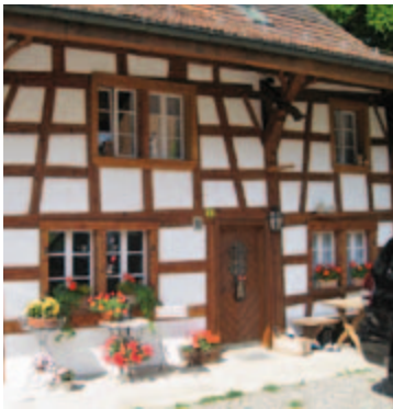
Totalrenovation eines Riegelhauses.
